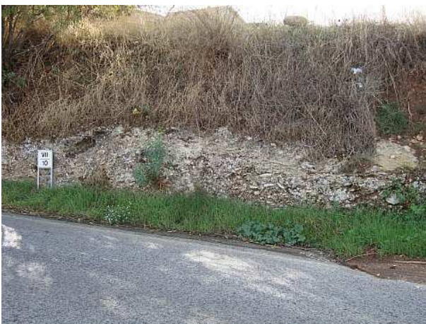
ghiaia e ciottoli in matrice sabbioso-marnosa in prossimità del km 10+700
