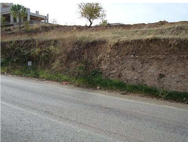
ghiaia e ciottoli in prevalente matrice sabbiosa tra il km 10+750 ed il km 10+800 circa
